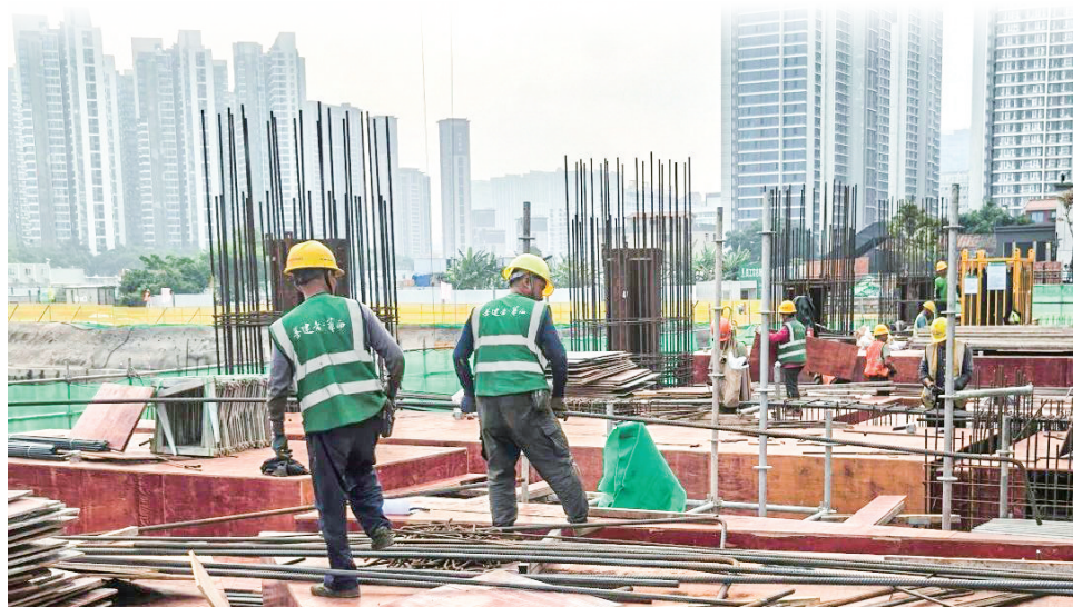
“五一”期间,工人们坚守在厦门国际商务核心区A1地块项目建设现场。
